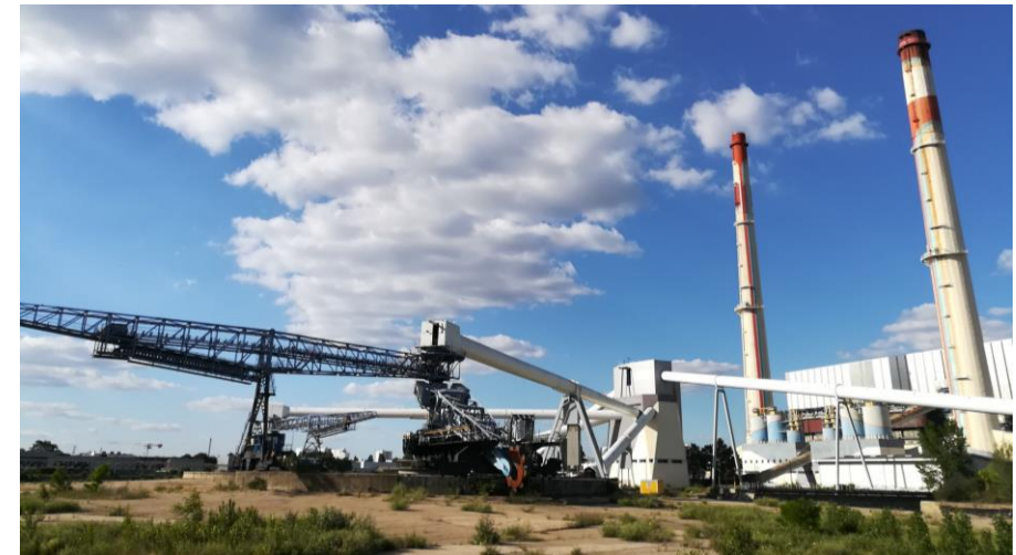
Centrale EDF, Vitry-sur-Seine (© CDT94 – T. Guillot)
