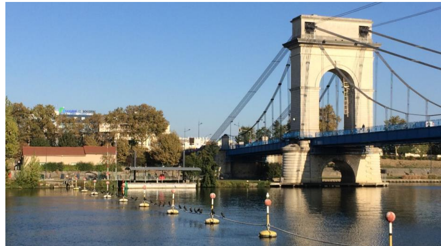
Pont du Port à l'Anglais, Vitry-sur-Seine (© CDT94)
