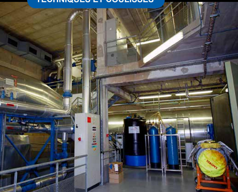
Centrale de Géothermie © SEMHACH
