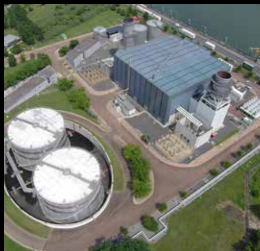
Centrale EDF Arrighi © EDF
